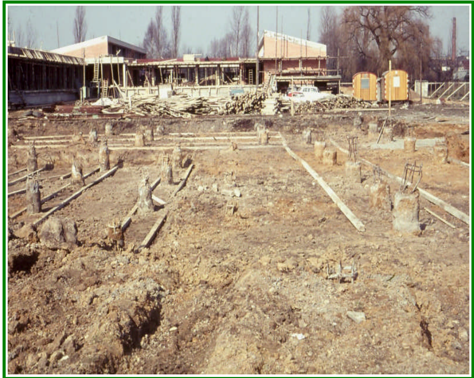
Gründung auf Beton- Pfählen
