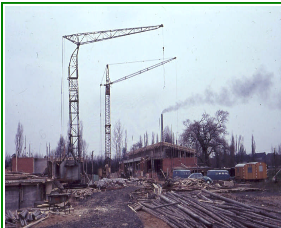
Baustelle für das Hauptgebäude
