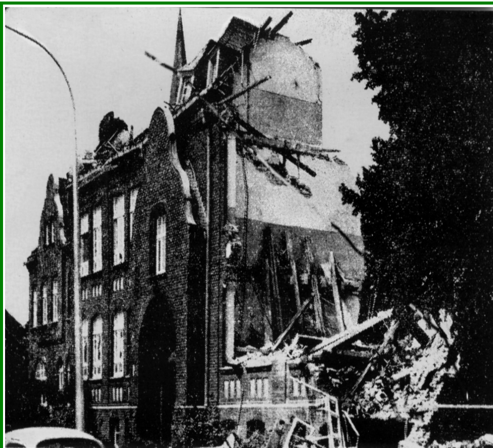
Nach der Inbetriebnahme des Schulzentrums wurde die Nordschule 1967 abgebrochen
