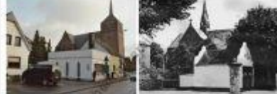
Marktplatz: Milbrunnen mit 1. Spritzenhaus (Vorn)
