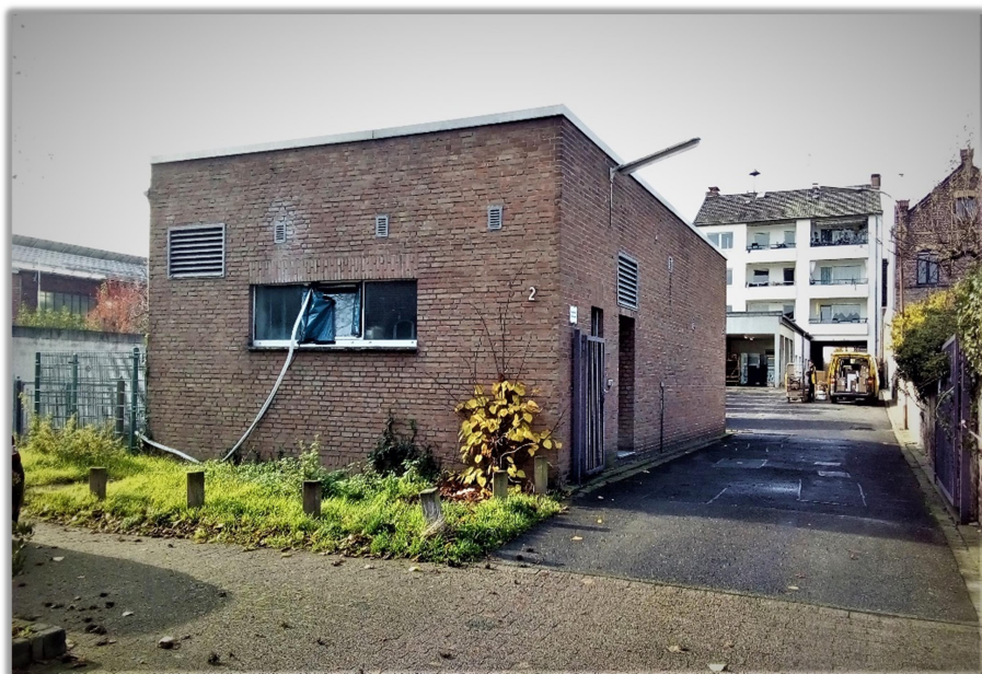
Die Fernsprechvermittlungsstelle Oedt an der Albert-Mooren-Allee besteht heute noch (Foto von 2020).
