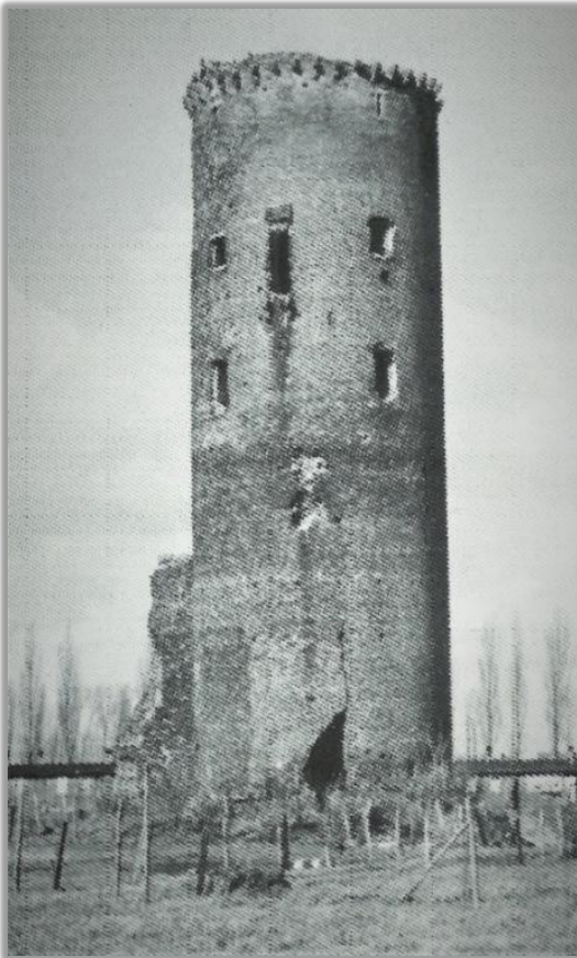
Abb. 9: Burg Uda vor der Restaurierung 1957
