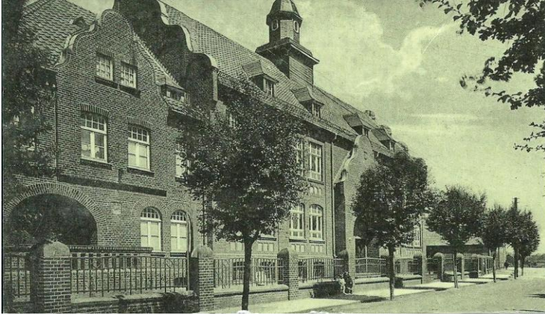
Katholische Knabenschule Nordstraße mit Lehrerwohnung links heute Tönisvorster Straße
